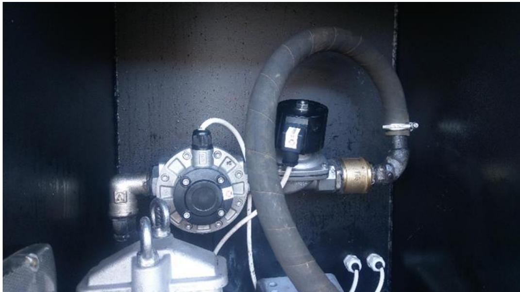
Рисунок 8 – Установка счётчика жидкости с импульсным выходом «Darkont» и электромагнитного клапана отсечки
