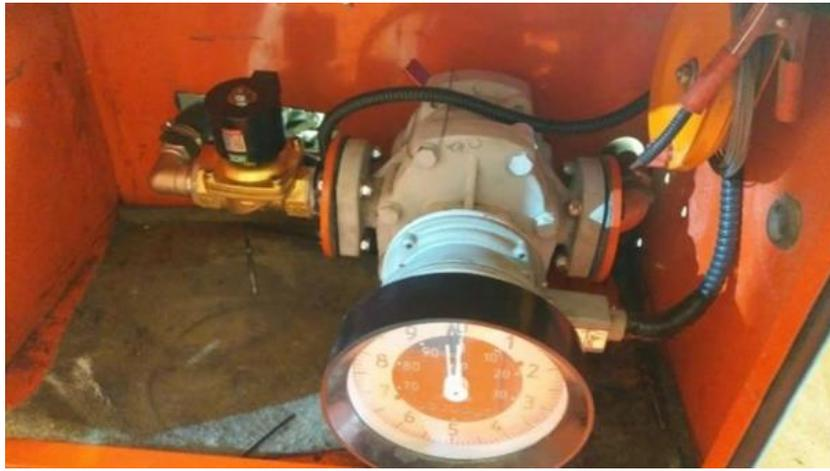
Рисунок 7 – Установка на счётчик жидкости ППО-40-0,6-СУ устройства генерации электрических импульсов УСС-Б-70 и клапана отсечки
